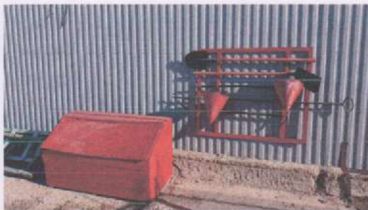
4 – сурет: Өрт сөндіру қалқаны (жылыту қазандықтары орналасқан ғимарат)
